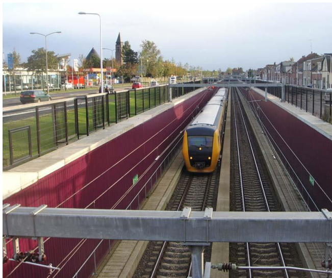
Spoorbaan open bak, Almelo Verdiept
