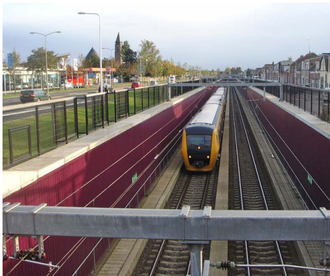
Spoorbaan open bak, Almelo Verdiept
