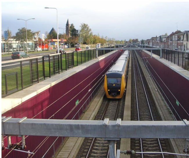
Spoorbaan open bak, Almelo Verdiept
