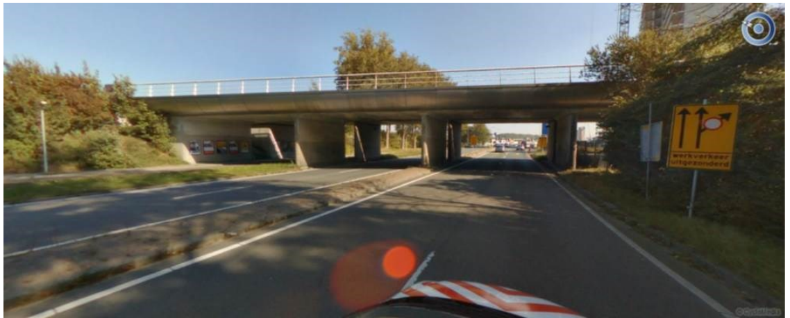
Betonnen spoorviaduct over een weg
