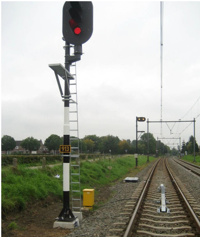
Afbeelding 9. Plaatsing krokodil
