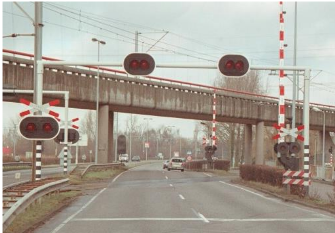
Overwegportaal met twee palen en een uitlegger
