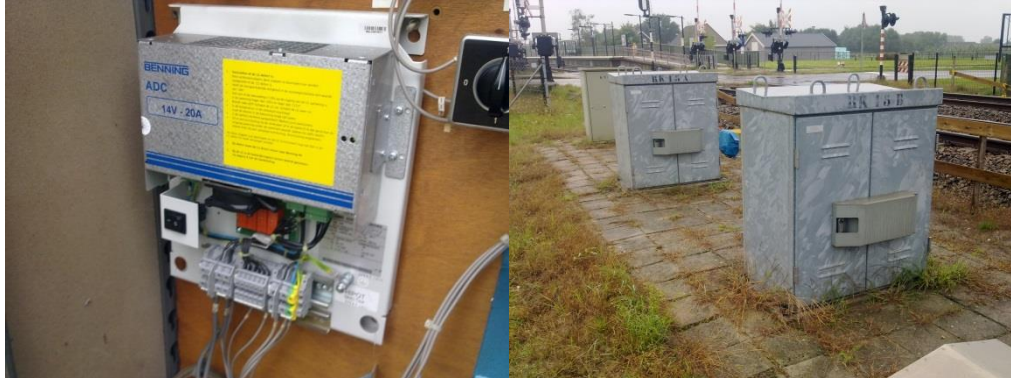
Laadgelijkrichter en RK-kast
