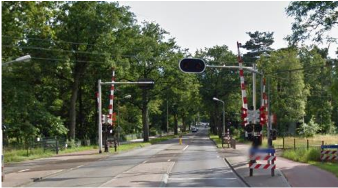
Figuur 10: Overwegportaal met één paal en een uitlegger
