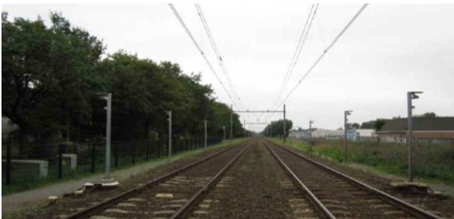
Anti-suicide verlichting links en rechts van de baan aan één zijde van de overweg.
