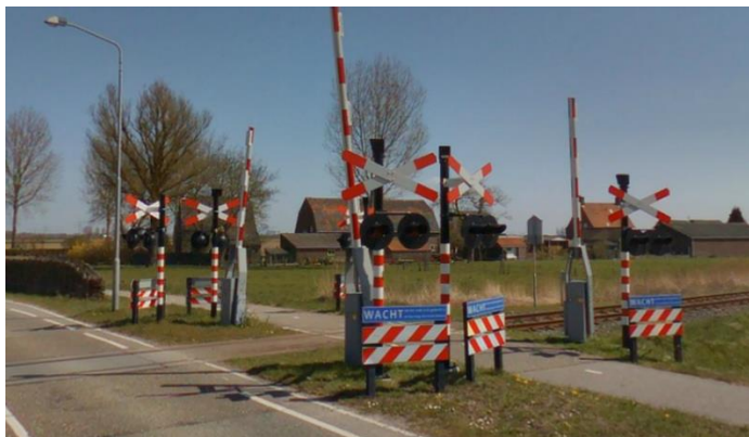
Paalinstallaties en losse overwegstellers
