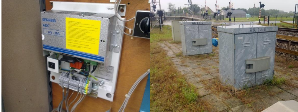
Laadgelijkrichter en RK-kast
