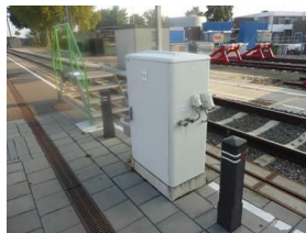
Persluchtaansl. (links onder de elektra aansl.)
