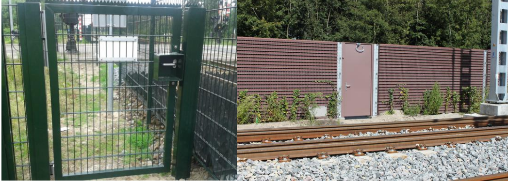
Toegangspoort in hek en geluidsscherm
