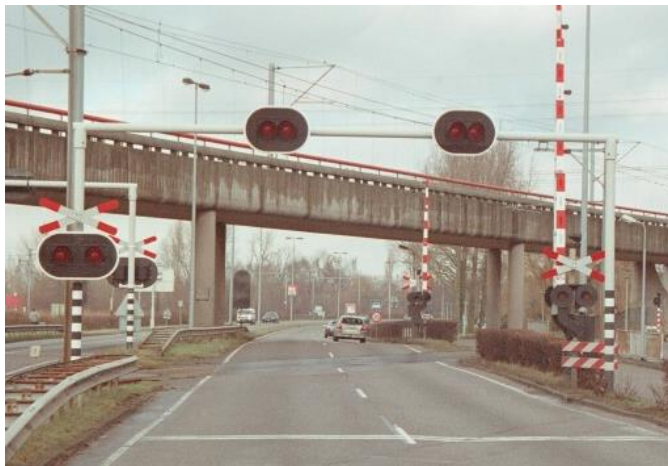
Overwegportaal met twee palen en een uitlegger
